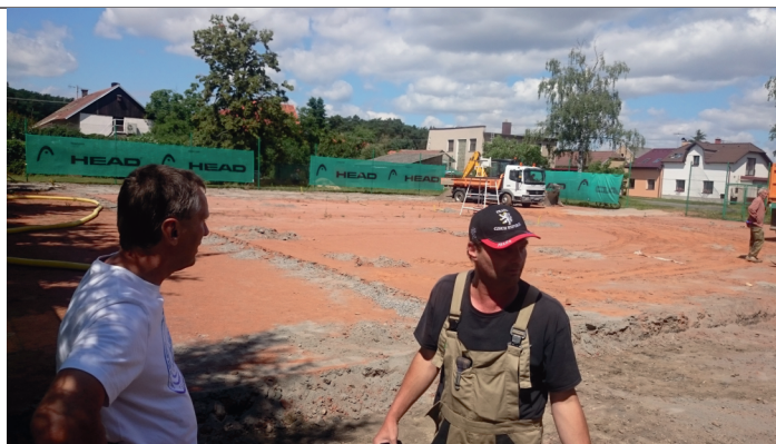
Odtěžení nepropustných vrstev tenisového hřiště.
